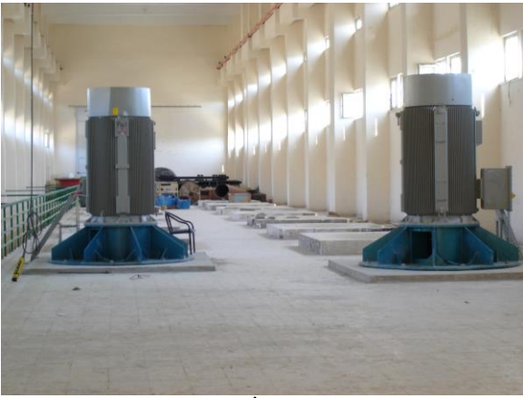
Resim 3. Kuzova Pompa İstasyonu Motor Katı
