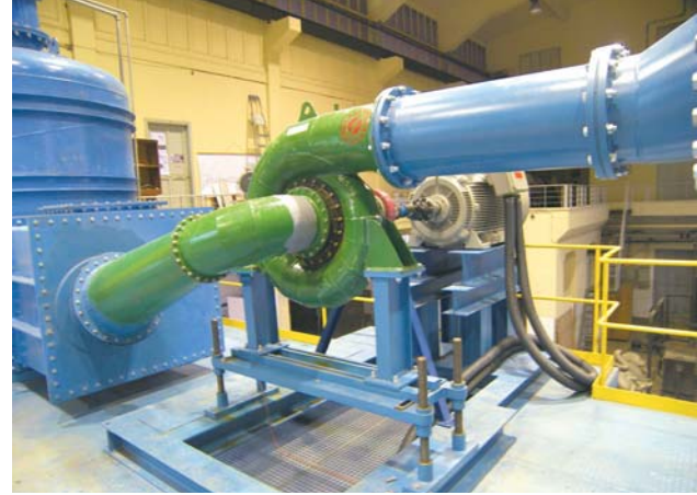
Şekil 6. Türbin ve emme borusu.
