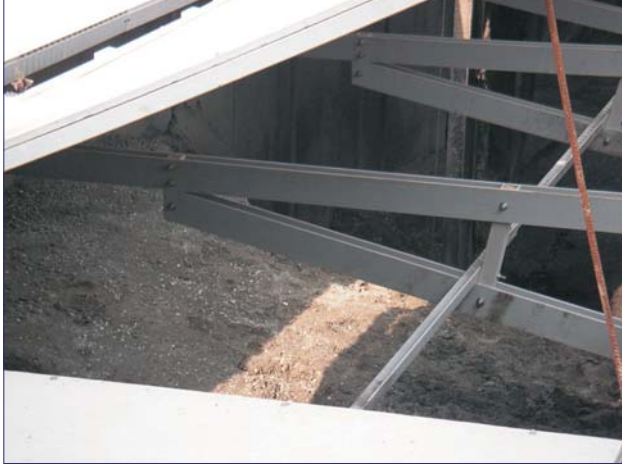
Şekil 3. Ataköy İleri Biyolojik Atıksu Arıtma Tesisi Ana Terfi Merkezi'ne gelen kum ve çakıl.
