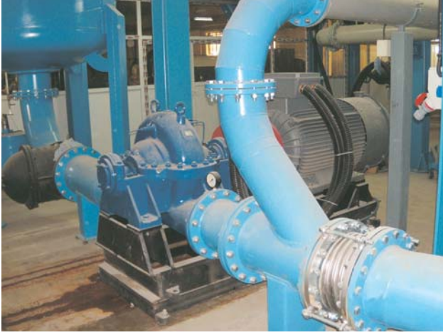
Şekil 4. Düşü yaratma amacıyla kullanılan çift emişli pompa.
