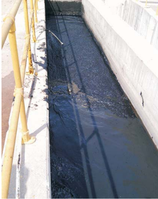
Şekil 4. Tuzla İleri Biyolojik Atıksu Arıtma Tesisi Ana Terfi Merkezi'ne gelen aşındırıcı malzemeler.
